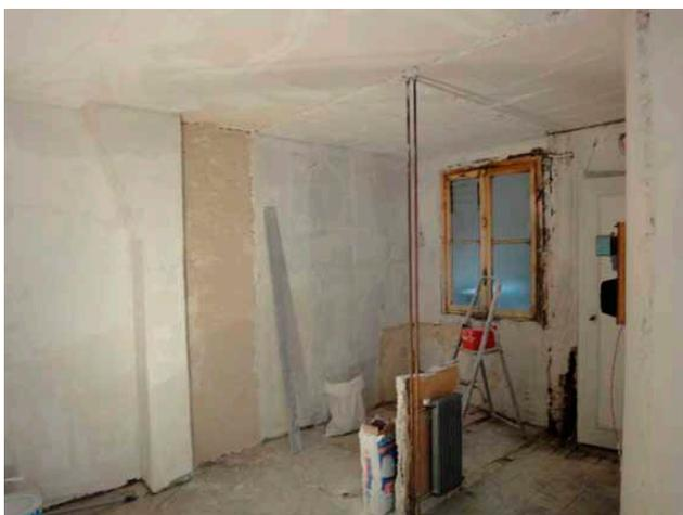
La cloison a été abattue. Première surprise, un radiateur se cachait dans un coffrage en bois et deux tuyaux d'alimentation traversent le sol et le plafond. Ces tuyaux appartiennent à la copropriété, il est donc impossible de les couper. Nous allons contourner le problème en donnant une forme de L au bar et en coffrant les tuyaux afin de donner l'impression qu'il y a une poutre.
