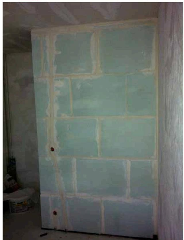
Le mur entièrement monté avec deux saignées dans lesquelles passent les câbles électriques.
